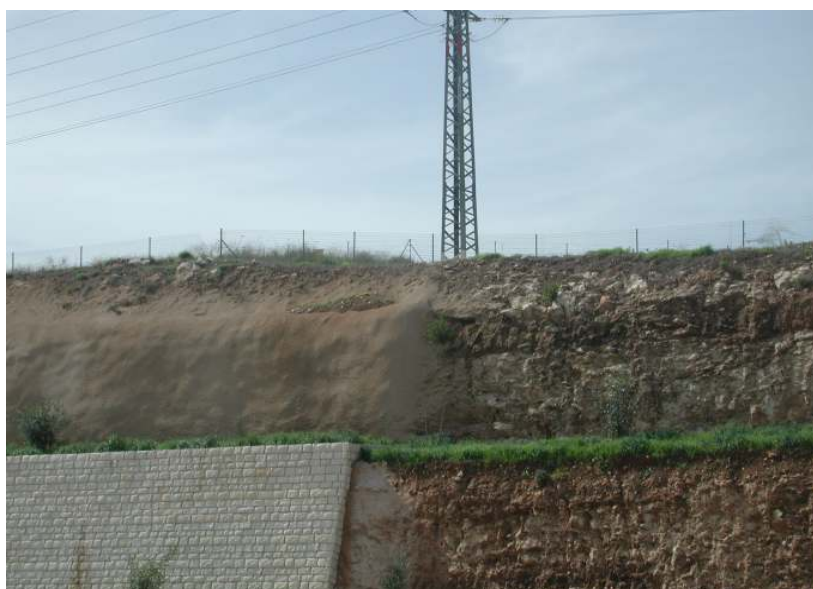
תמונה מס' 2-5.7 ייצוב מדרון כנ"ל תמונה 4. (צולם בכביש 6 בין מחלף נחשונים לבין שמן מערב)
