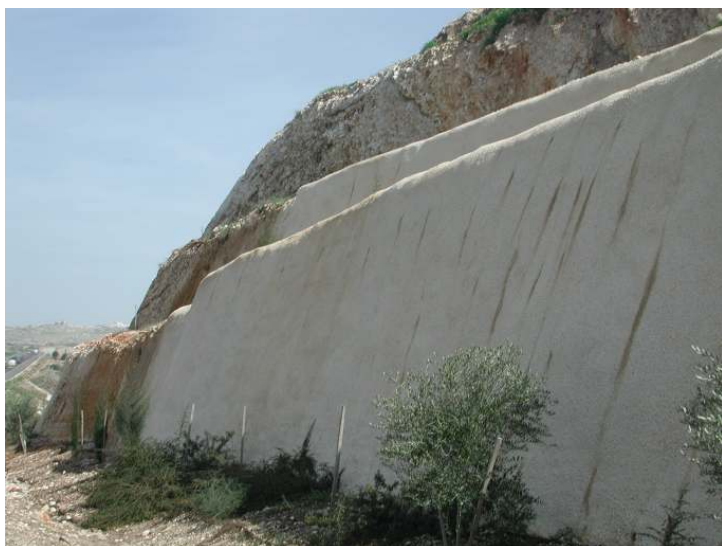
תמונה מס' 1-5.7 ייצוב מדרון באמצעות מסמרי קרקע והתזת בטון מזוין. (צולם בכביש 6 צפונית למחלף בן שמן מזרח)
